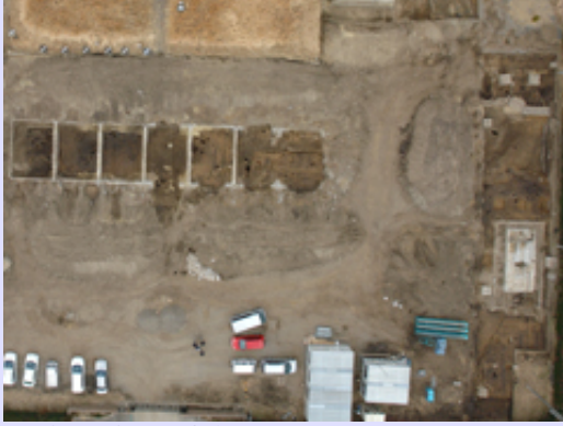
調査区全景(空撮)
