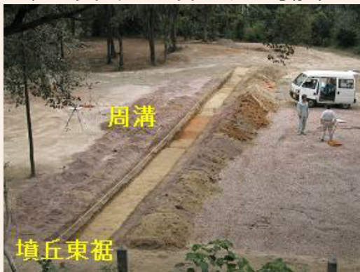
試掘トレンチ
