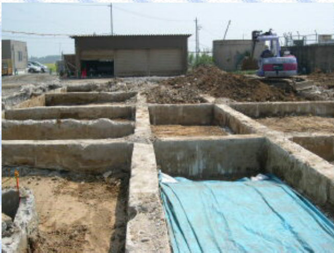
病棟の基礎が残る中を掘る。
