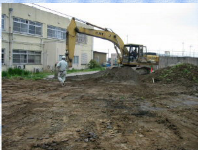
11次調査区表土除去
