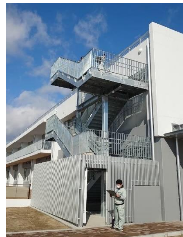
津波避難施設
