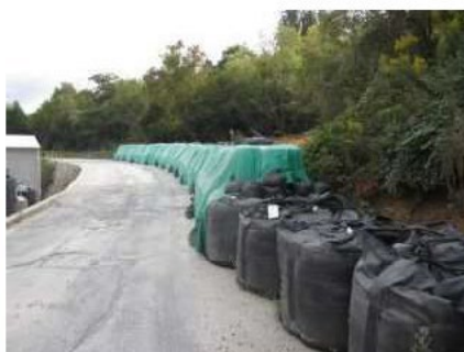
敷地境界に土嚢を設置
