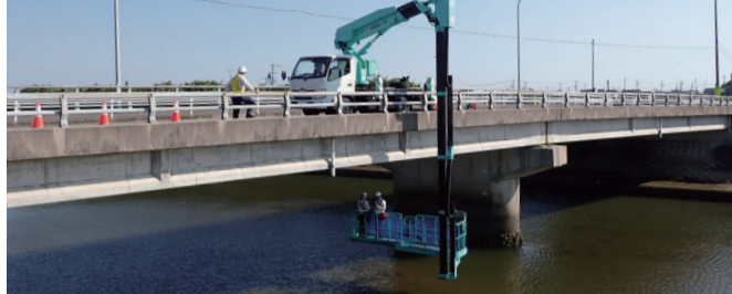
▲点検中の栄橋
