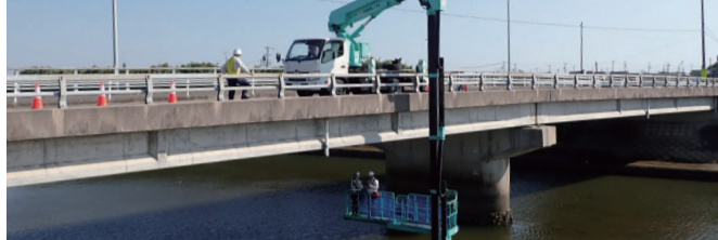
▲点検中の栄橋
