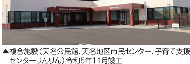
▲複合施設（天名公民館、天名地区市民センター、子育て支援センターりんりん）令和5年11月竣工
