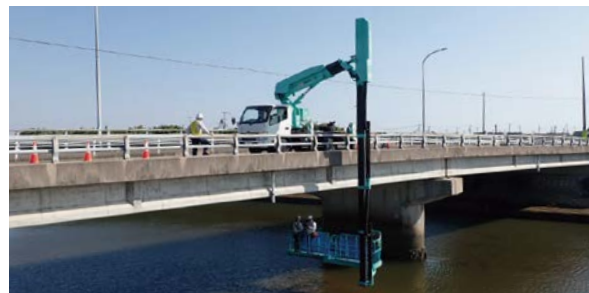
▲点検中の栄橋
