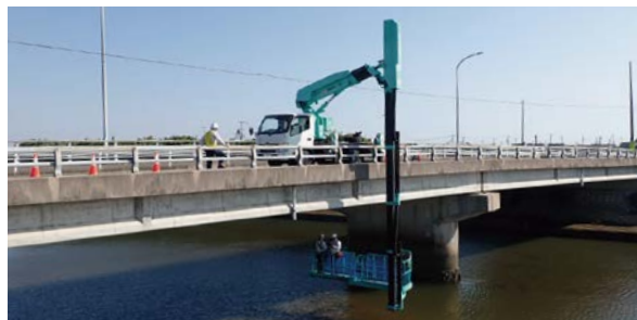
▲点検中の栄橋
