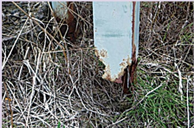
▲支柱基礎部の腐食
