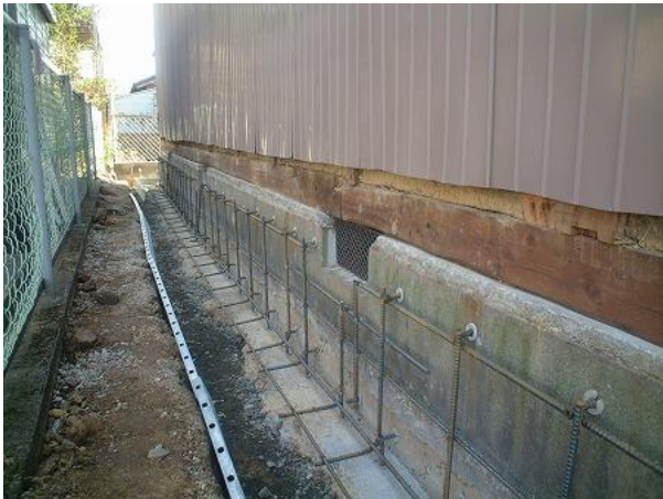
図-15 耐震補強工事の状況
