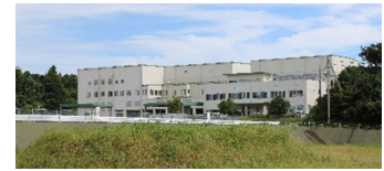
不燃物リサイクルセンター
