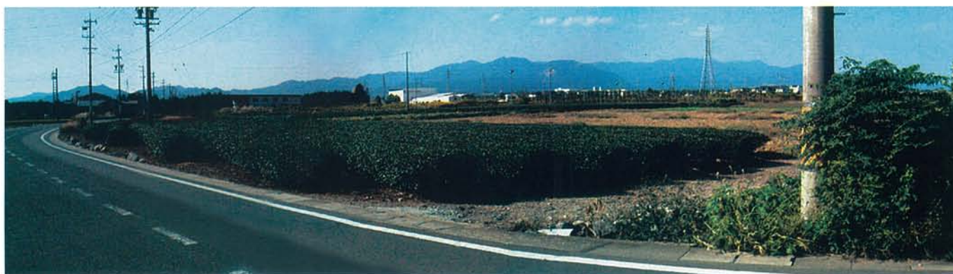
写真－10 A-1地区北端中央から県道辺法寺・加佐登停車場線を挟んでC地区方向を見る
