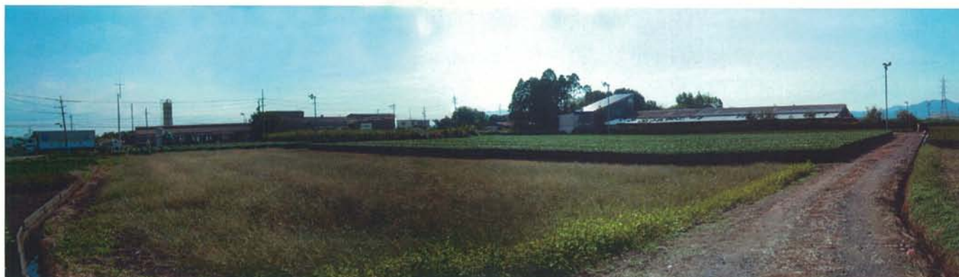
写真-4 A-2地区北東端から史跡指定地を見る
