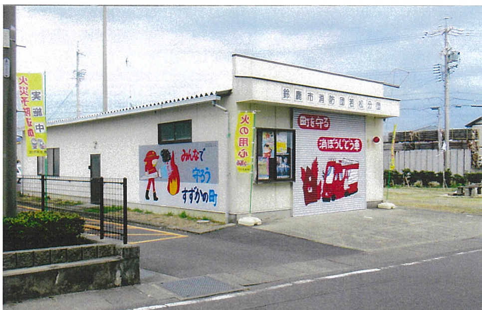
＝塗替えられた消防車庫＝
