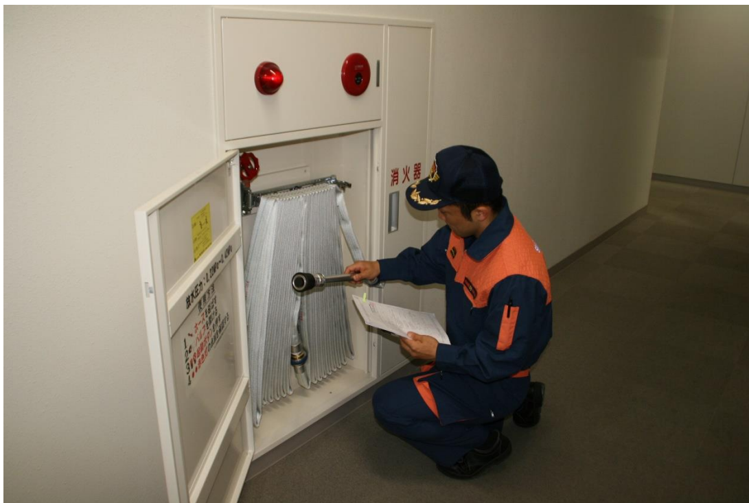
消防用設備検査
