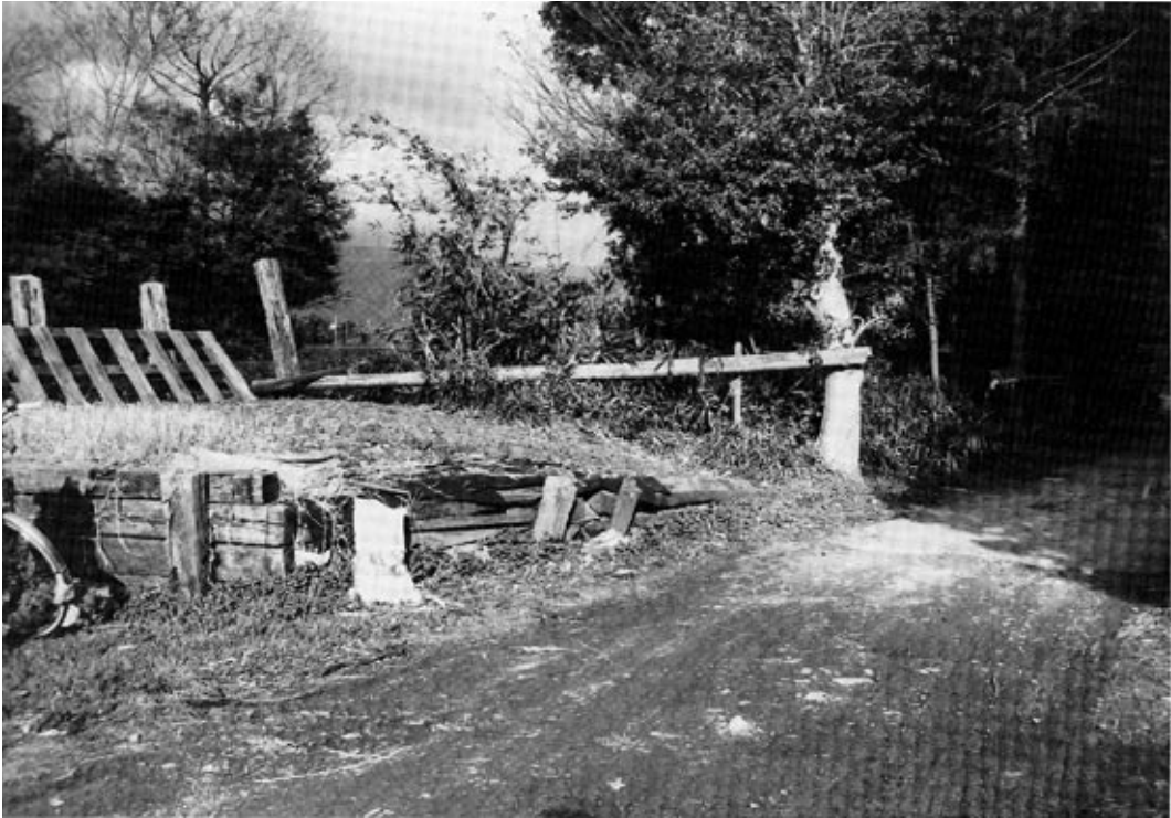
南野 1 地区土塁 (南より)
