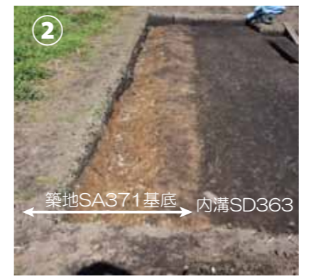
6AFF-B-1区 長塚南東区西辺築地塀 (南から)
