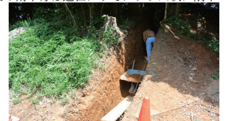
西斜面トレンチ掘削作業
