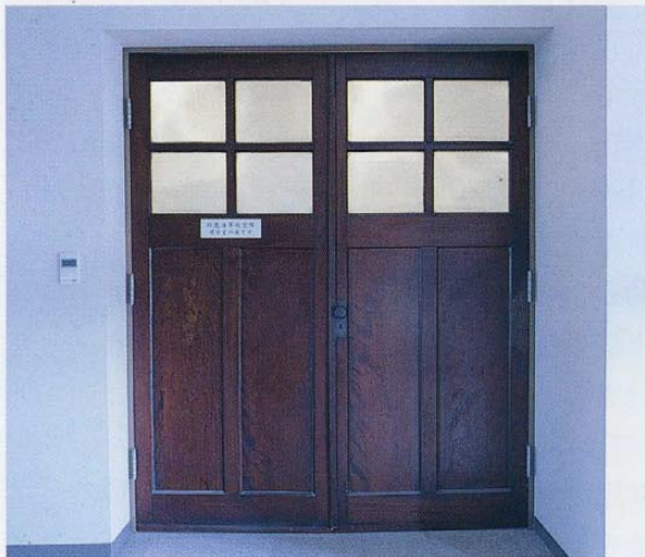
鈴鹿海軍航空隊司令室の扉 香良洲町歴史資料館に移設保管されている
