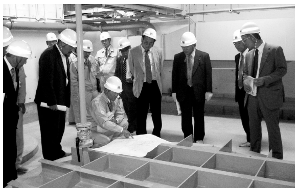
〔建設水道委員会〕平成21年4月13日 小山雨水ポンプ場
