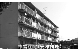
市営住宅(安塚団地)
