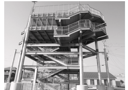
避難タワー（静岡県焼津市）
