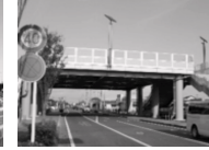
歩道橋一体型の津波避難タワー
