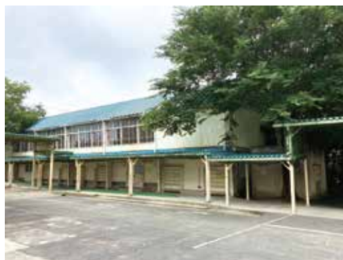
石薬師小学校 現在の屋内運動場
