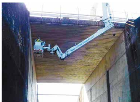
加佐登40号橋調査状況 (橋りょう長寿命化事業)
