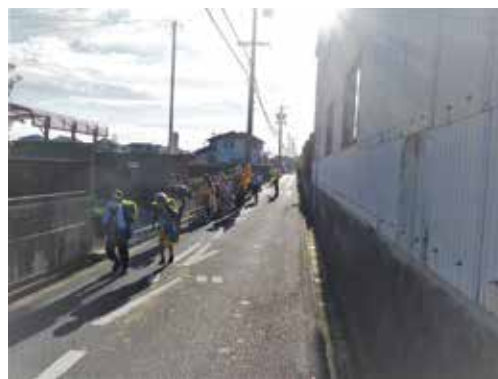
交通安全対策事業を実施予定の道路 (河曲地区、市道河田189号線)
