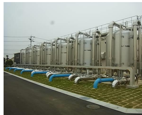
除鉄・除マンガン設備(平田送水場)
