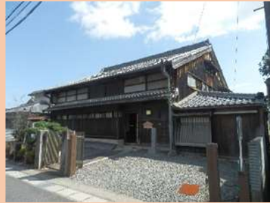
東海道庄野宿のまちなみに残 る旧小林家住宅
