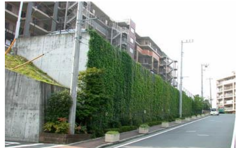
無機質なコンクリート擁壁をツル性植物で緑化し、景観的影響を緩和している。（他市）
