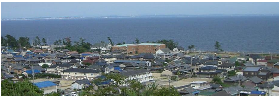
海岸沿いの眺望を遮らないよう、松並木を遮らない高さに抑えられている。(写真中央の建築物)
