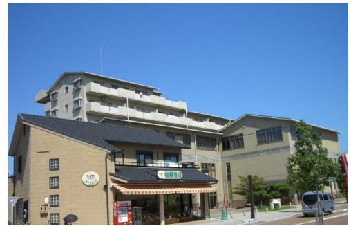
建築物の高層部を敷地境界から後退させることで、周辺のまちなみとの違和感や圧迫感を緩和している。
