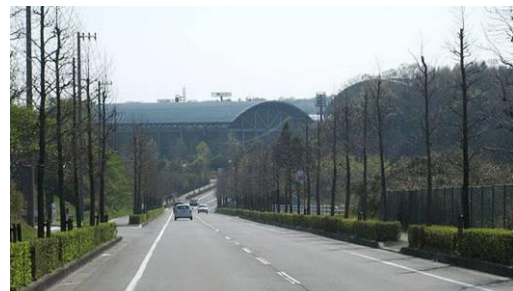
屋根形状の工夫により、周辺の自然的景観と調和している。
