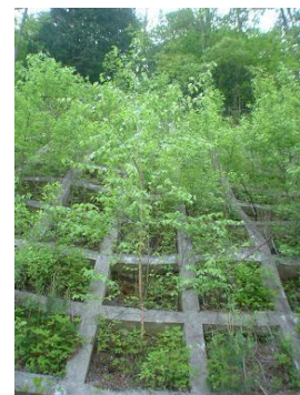
周辺の樹種で法面を緑化した事例 (出典：全国SF緑化工法協会HP)
