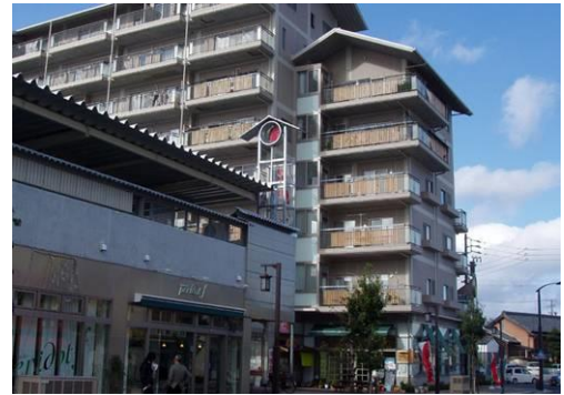
勾配屋根の採用やバルコニーの修景などにより、周辺のまちなみと調和を図っている。
