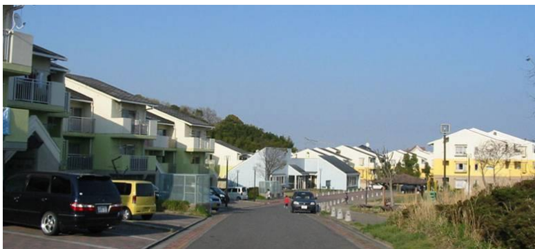
一戸建てが大半を占める住宅団地の中で、集合住宅を分節化することでボリューム感を低減し、周辺との調和を図っている。
