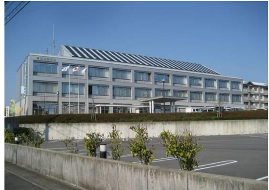
屋上の設備を飾り屋根で覆い，建築物に取り込んでいる。
