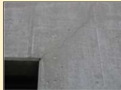
【コンクリートの乾燥収縮ひび割れ】
