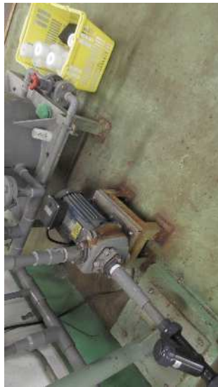
No. 2032 高度処理設備 サンプリングポンプ
