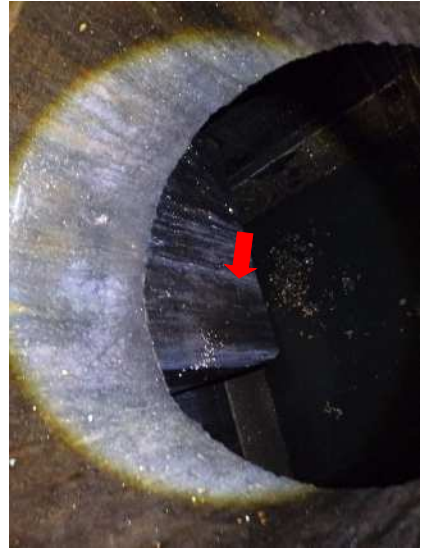
No. 1018 1階 投入室 洗車排水槽 水槽
