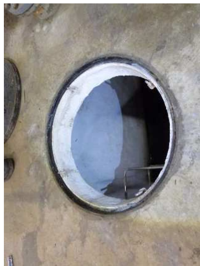
No.1057 2階 処理室 砂ろ過処理水槽 マンホール・水槽（西側） マンホール枠や表面に全体的 な白い堆積物があるが、特に異 常は見られない。 水槽内には特に異常は見られ ない。
