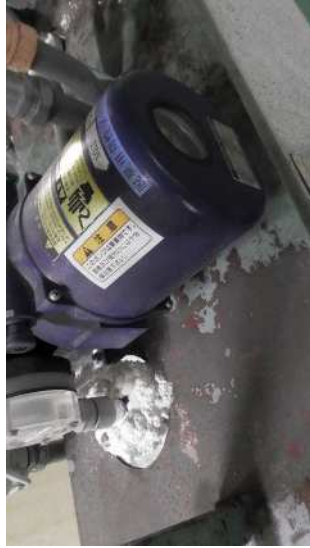
No. 2050 脱臭設備 苛性ソーダポンプ (No.1)
