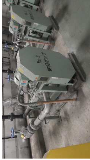
No. 2035 汚泥処理設備 給泥ポンプ (No.3)
