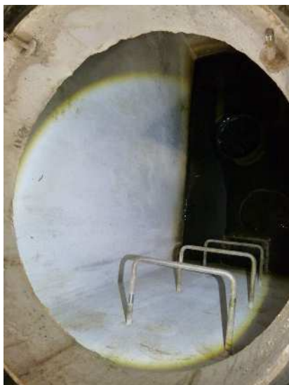
No.1056 2階 処理室 砂ろ過原水槽B 水槽（西側） 水槽内には特に異常は見られ ない。
