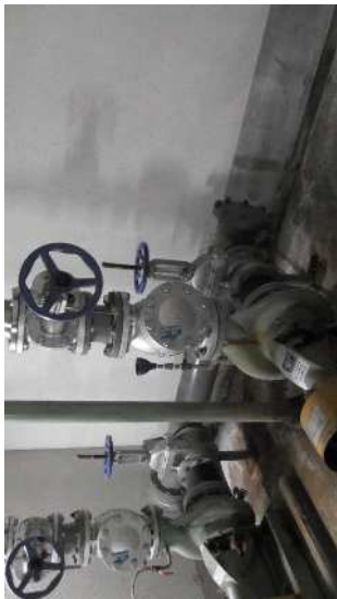
No. 2025 高度処理設備 逆洗ポンプ
