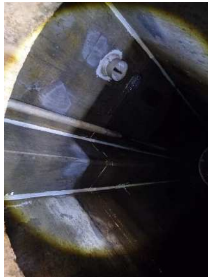
No.1060 2階 処理室 新炭貯槽 水槽（北側） 水槽内に特に異常は見られな い。（現在不使用）
