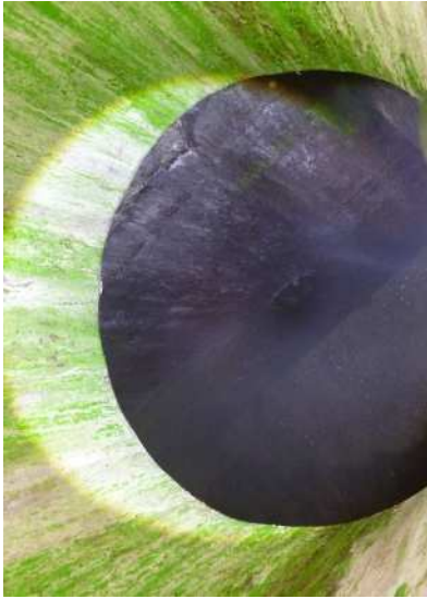
No. 1016 1階 投入室 し尿貯留槽 水槽 (投入室中央付近)
