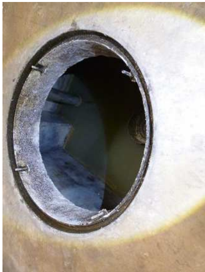
No.1047 2階 処理室 凝集槽B マンホール（東側）
