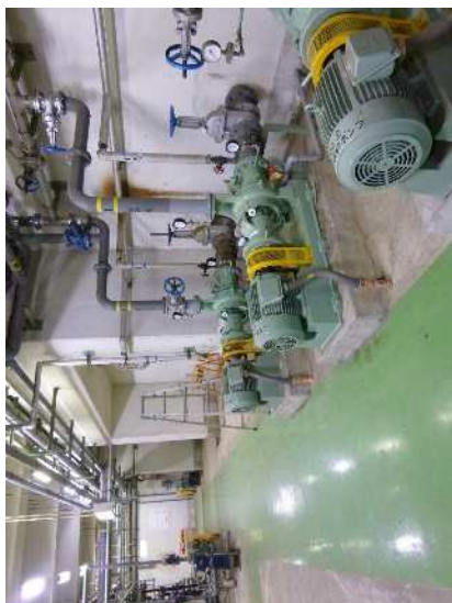
No. 1140 処理棟 1階 管廊 (No.1し尿破砕ポンプ廻り)
