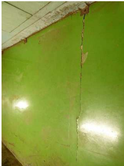
No. 1149 処理棟 2階 脱臭室 (13-16 通り間) 床面にひび割れが見られる。 (拡大部)
