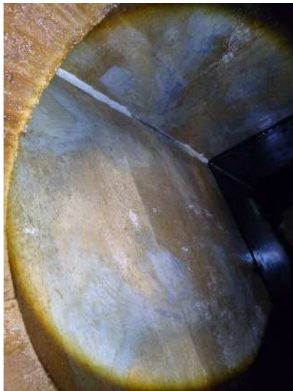
No.1059 2階 処理室 活性炭処理水槽 水槽（北側） 水槽内に特に異常は見られな い。
