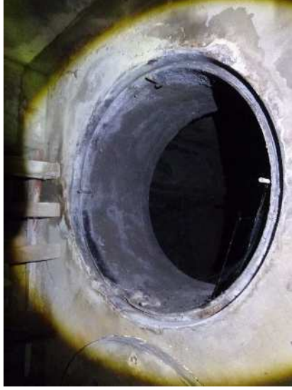
No. 1065 2階 処理室 消毒槽 マンホール マンホール蓋・枠や開口周囲の表面に汚れが見られるが、特に異常は見られない。
