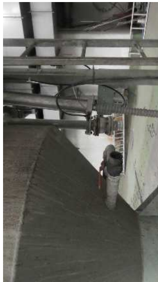
No. 2002 受入貯留設備 沈砂タンク
