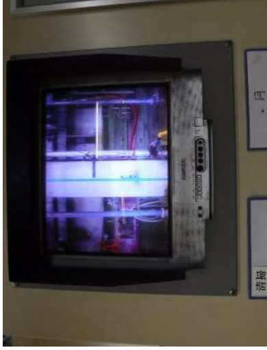
No. 3010 中央制御室 中央監視盤用 ITV モニタ ブラウン管の耐用年数を越えているようなので、液晶型モニタに更新の検討が必要。
