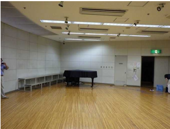
遮音性能 測定状況（3F 音楽室）
