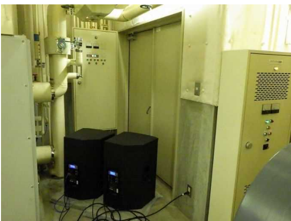
遮音性能 測定状況（2F 機械室）
