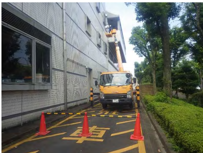
写真 7-1-2 高所作業車による調査状況
