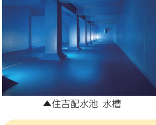
▲住吉配水池 水槽
