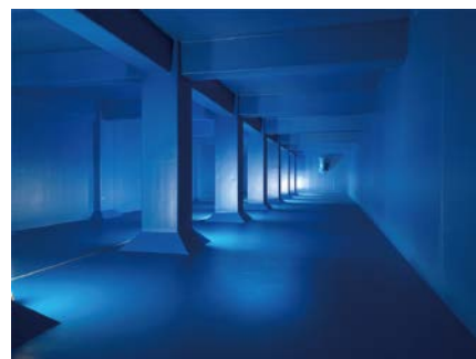
▲住吉配水池 水槽
