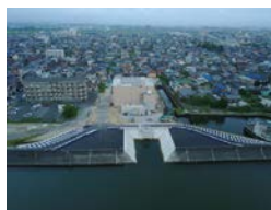
▲なごさき 渚 雨水ポンプ場
