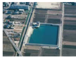
▲旭が丘雨水調整池
