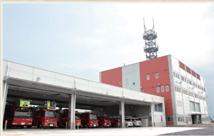
▲建て替えられた消防新庁舎
