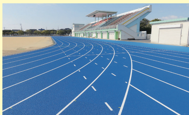
改修工事が行われるAGF鈴鹿陸上競技場
