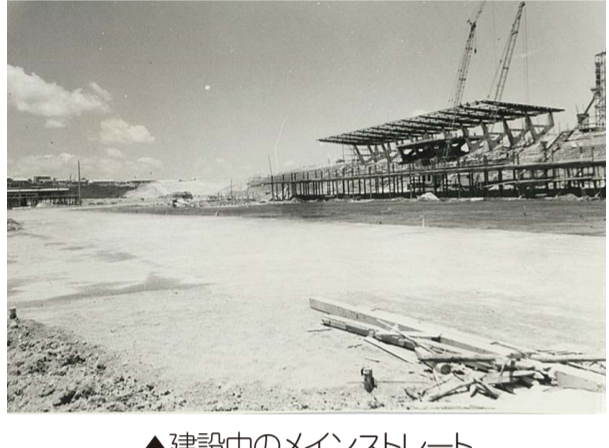
▲建設中のメインストレート
