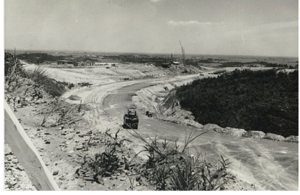
▲建設中の最終コーナー
