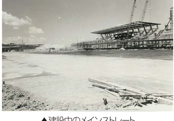
▲建設中のメインストレート
