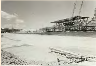
▲建設中のメインストリート
