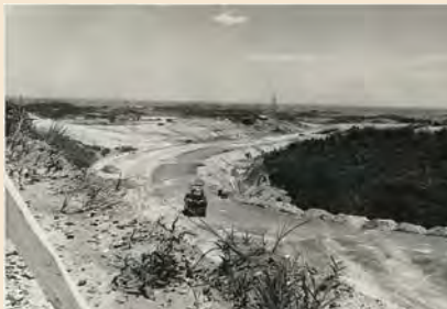
▲建設中の最終コーナー
