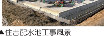
▲住吉配水池工事風景
