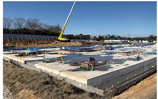
▲住吉配水池工事風景
