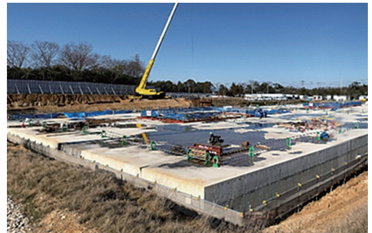
▲住吉配水池工事風景
