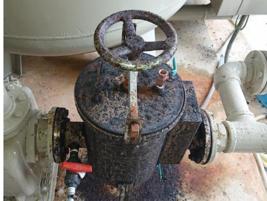
ろ過設備の腐食
