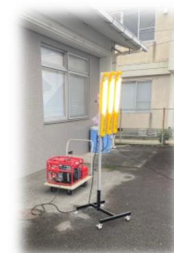
▲発電機や照明の動作確認
