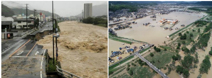
出典：国土交通省中国地方整備局 HP 写真左：広島県広島市安芸区中野東 国道2号被災 写真右：岡山県倉敷市真備町 小田川堤防決壊
