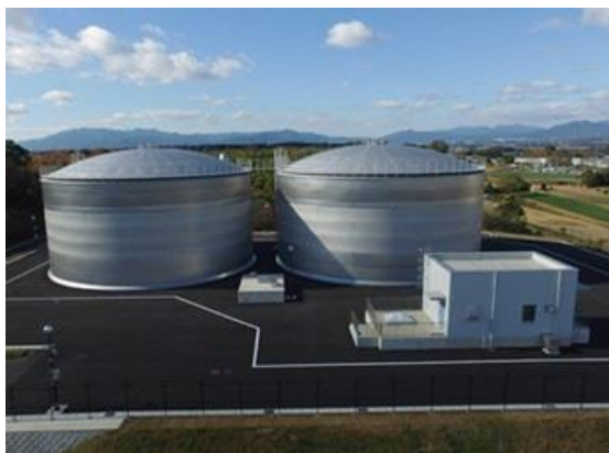
【国府第2配水池】
